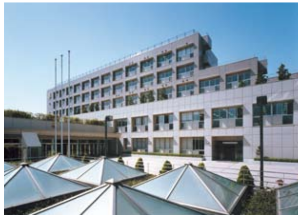
1998年10月完成の校舎(手前はトップライト)
